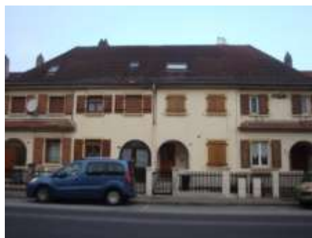
Maison ouvrière regroupant 4 appartements, 14 à 19 rue Poincaré, Photo : OTE Ingénierie
