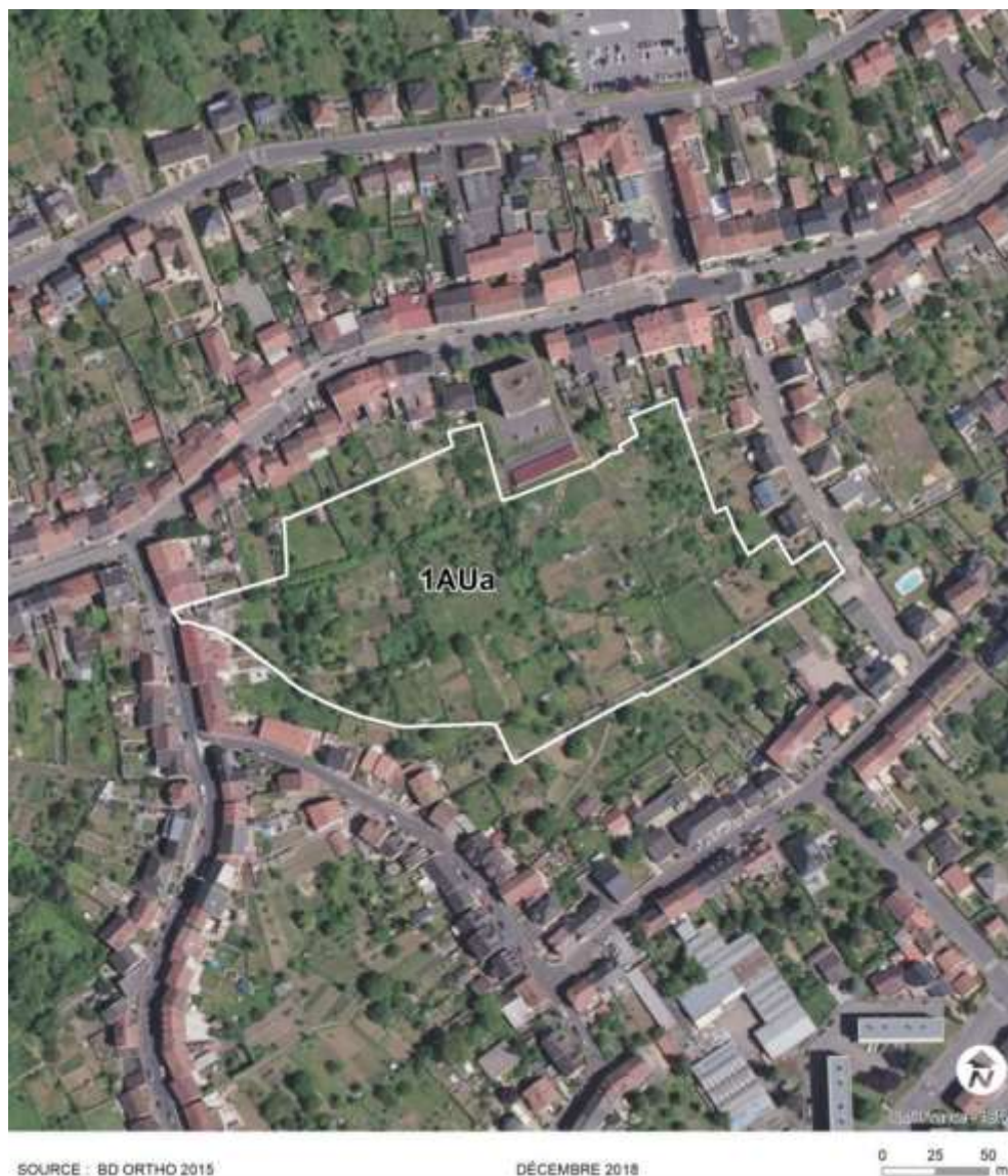
Vue aérienne de la zone 1AUa
