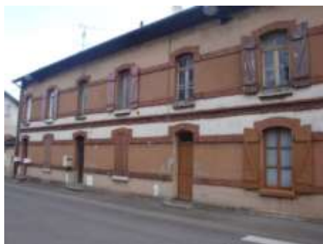
Maison ouvrière regroupant 3 appartements, 20 rue Clémenceau, Photo : OTE Ingénierie
