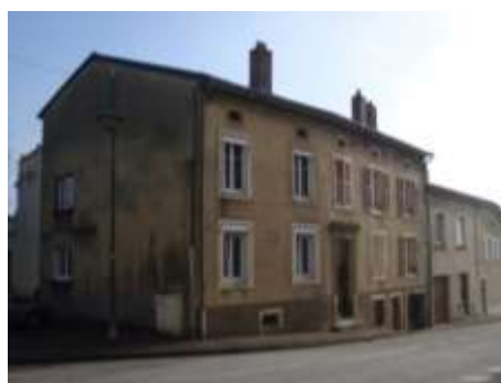
Bâti traditionnel lorrain, 2, rue Jeanne d'Arc, Photo : OTE Ingénierie
