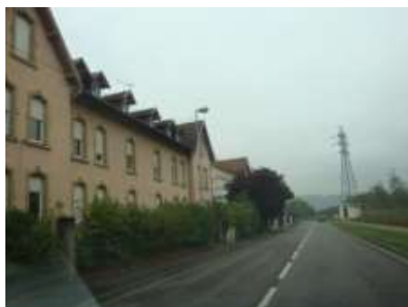
Immeuble de logements ouvriers – 24 rue de l'Usine, Photo : OTE Ingénierie
