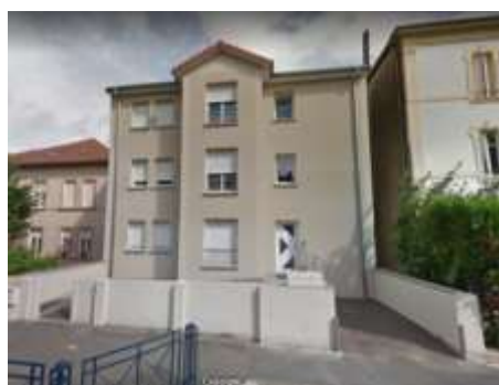
Parcelle minéralisée, clôture inadaptée, rue Foch
