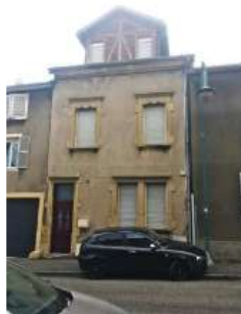
Création de lucarne inadaptée à la typologie architecturale traditionnelle
