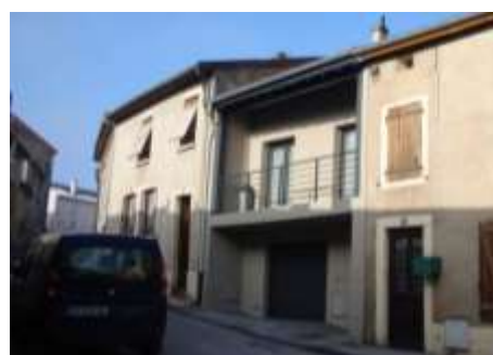
Aménagement d'une loggia en façade sur rue, Grand'rue
