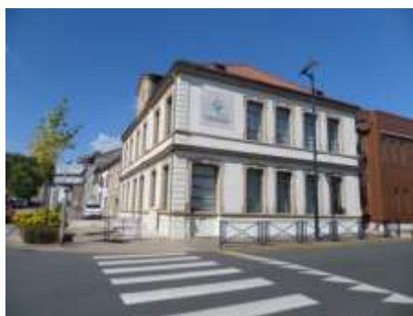
Siège de la CCPOM, Grand'rue, Source : OTE Ingénierie
