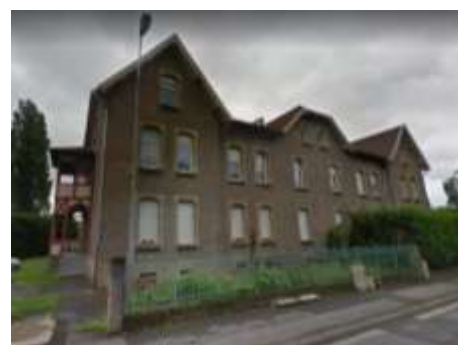
Immeuble de logements ouvriers – 7 rue de l'Usine, Images : Google'Map
