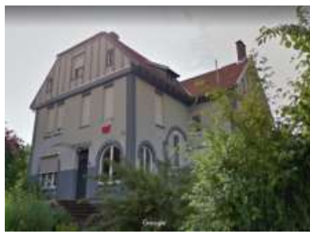
Couleur inadaptée, rue Foch
