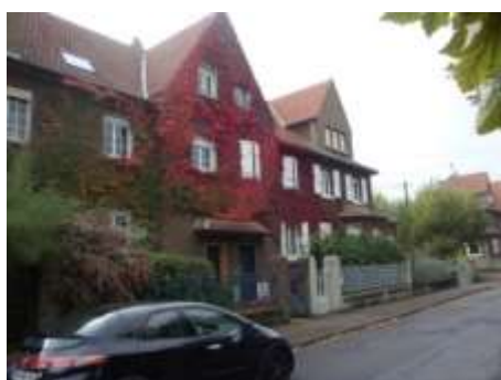
28 à 31 rue du Maréchal Joffre, Source : OTE Ingénierie
