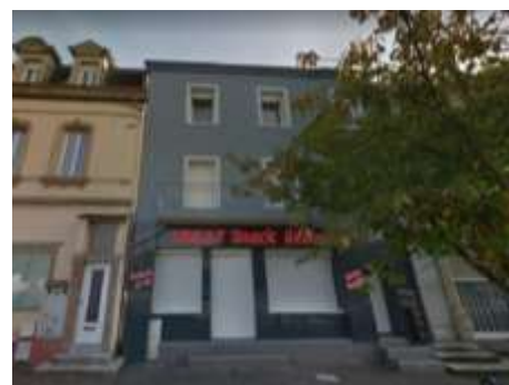
Isolation par l'extérieur détériorant l'ensemble de la façade et l'identité du bâti, rue de la Gare
