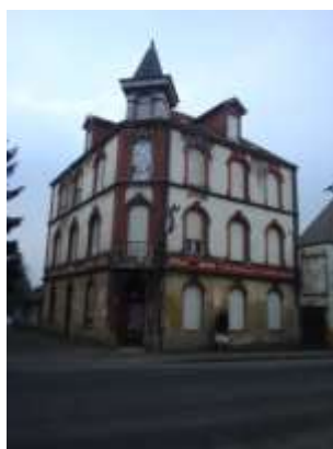
Immeuble d'habitations situé 3 rue Poincaré, Photo : OTE Ingénierie
