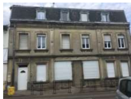
Maison de ville avec commerce au RDC – style art nouveau "architecture française", 82 Grand'rue, Photo : OTE Ingénierie
