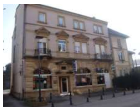
Immeuble de rapport d'inspiration néo-classique, 16 rue Raymond Mondon, Photo : OTE Ingénierie
