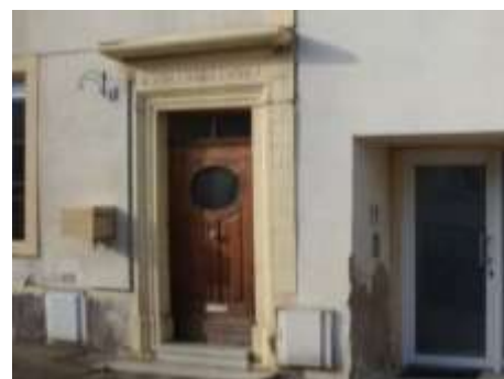
Encadrement d'une porte d'entrée en pierre de Jaumont (moulures, millésime...)
