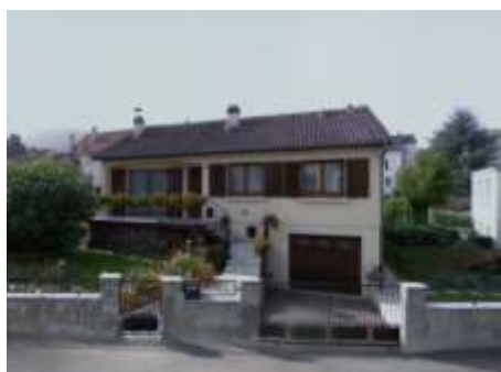
Maison des années 1980, 18 rue de Villers, Source : Google Maps
