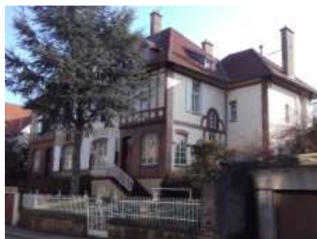
Villa jumelée, 12 rue de Maréchal Foch, Photo : OTE Ingénierie
