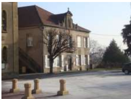
Presbytère, rue de l'Eglise, Source : OTE Ingénierie
