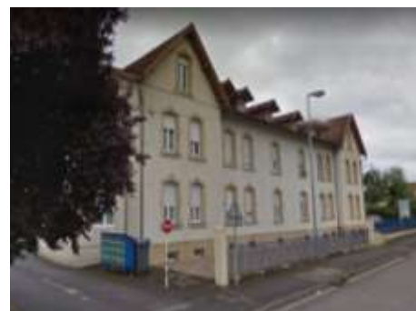
Immeuble de logements ouvriers – 22 rue de l'Usine, Images : Google'Map
