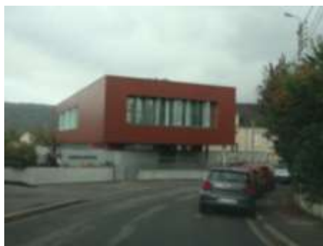
Maison du lien social, vu de la rue du Maréchal Lyautey, Source : OTE Ingénierie
