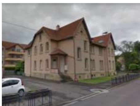
Immeuble de logements ouvriers – 13 rue de l'Usine, Images : Google'Map
