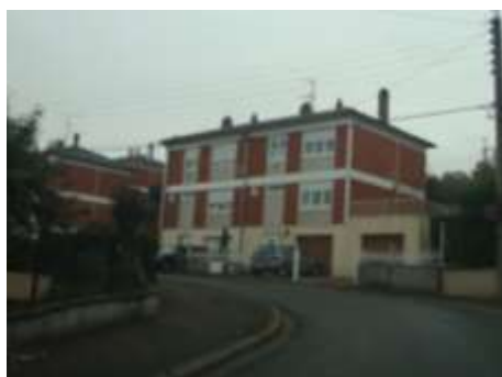
50 – 52 rue du Petit Moulin, 1968-1970, Source : OTE Ingénierie
