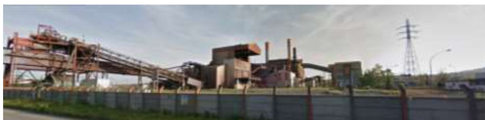
Usine d'agglomération de Rombas, construites dans les années 1960-1970, rue Poincaré
