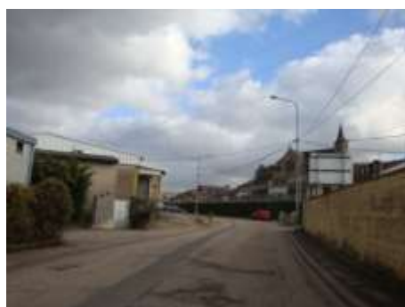
Bâti artisanal et commerciale, rue des Artisans, Photo : OTE Ingénierie
