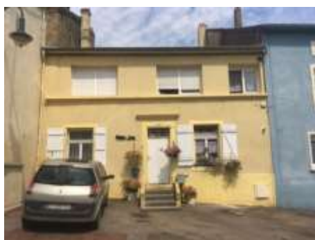
Surélévation d'une construction existante, ouvertures plus de proportions inadéquates (plus larges que hautes), Grand'rue
