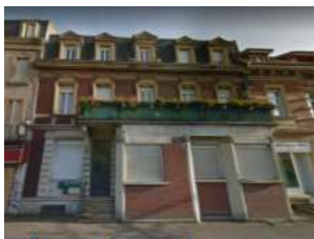
Extension de la façade sur rue à l'emplacement d'une ancienne vitrine, rue de la Gare
