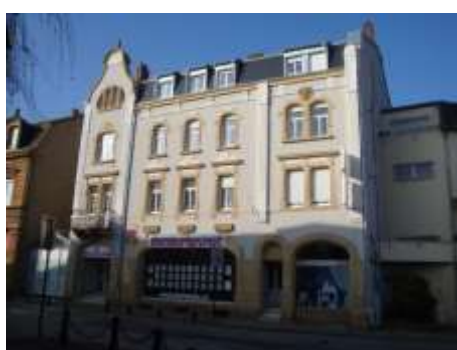
Immeuble de rapport d'inspiration néo-renaissance allemande, 13 rue de Mondon, Photo : OTE Ingénierie
