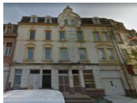
Restructuration du parterre commercial d'un immeuble sans respect d'ordonnancement de la façade, rue de la Gare
