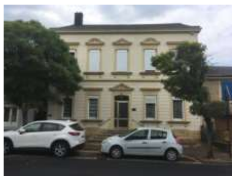
Hôtel particulier – ancienne maison du directeur des mines de fer de Rombas – style néoclassique, 22 Grand'rue, Photo : OTE Ingénierie
