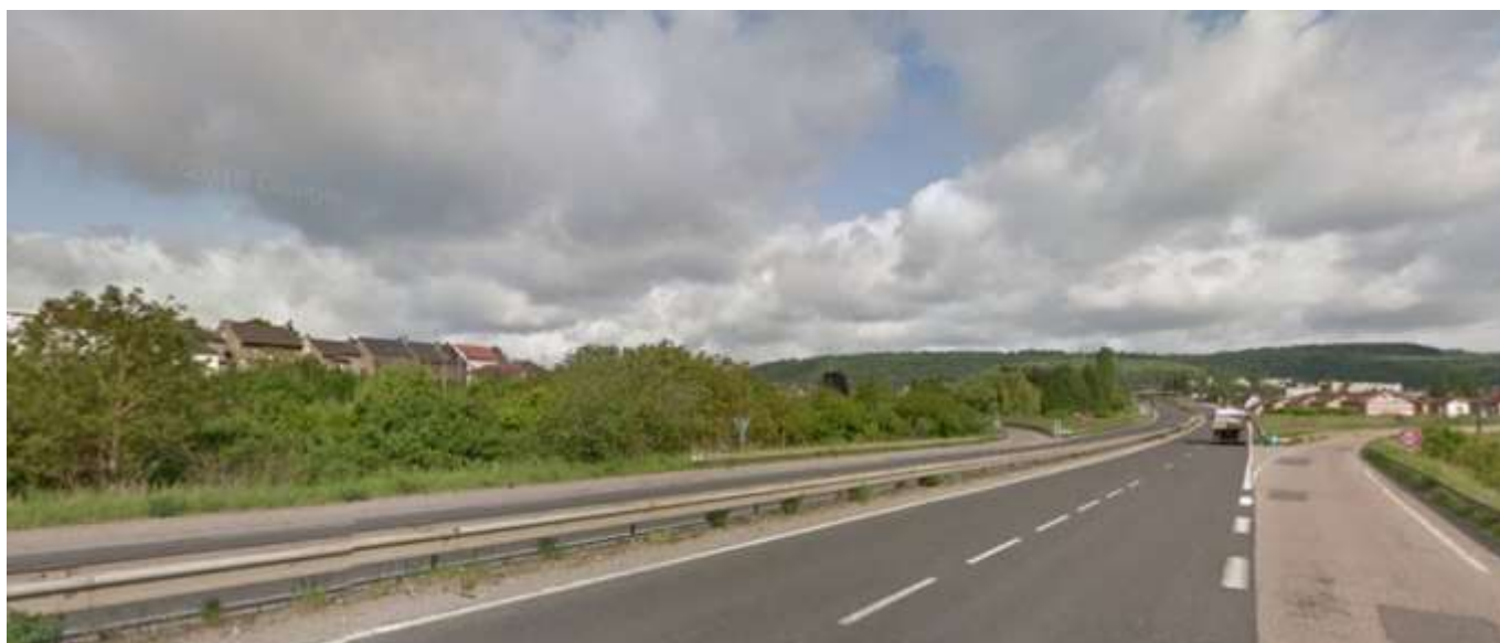
Ouverture du paysage sur les arrières de construction et les massifs boisés de Clouange
