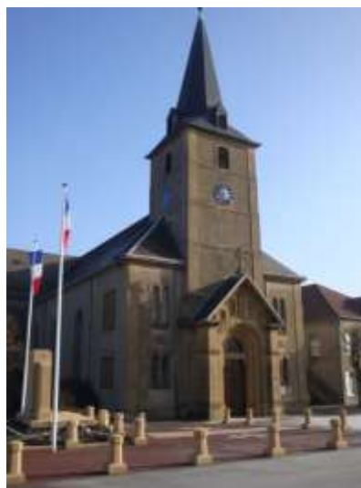
Eglise Saint-Rémy, rue de l'Eglise, Photo : OTE Ingénierie
