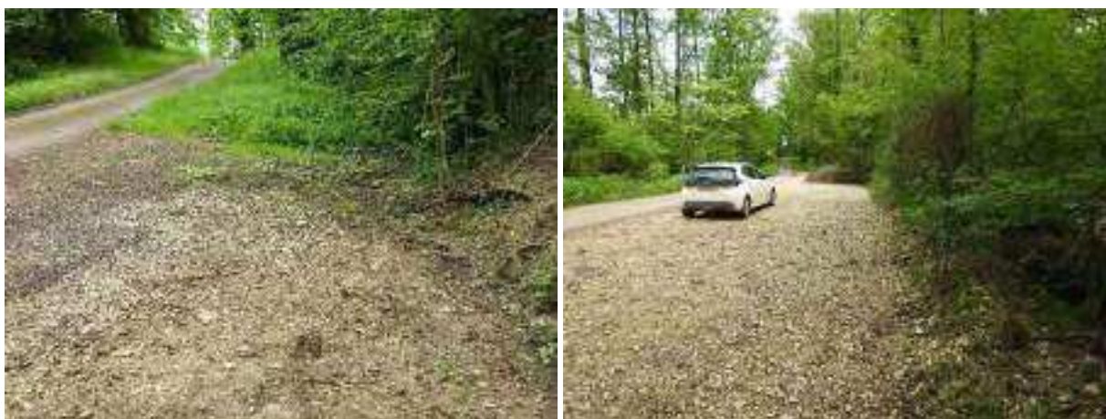
Figure 38 : L'accotement de la route d'accès
