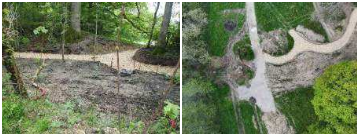
Figure 42 : Travaux de viabilisation réalisés début 2024
