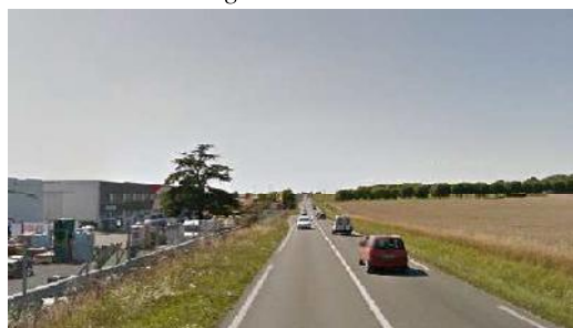
La RD constitue la limite entre la zone urbaine à l'ouest et l'espace agricole à l'est. Vue sur la zone d'activités et au fond à droite sur le Château de Didonne noyé dans la verdure
