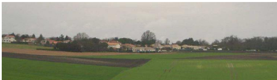
Les jardins et boisements (Bois de la Chasse à droite de l'image) constituent une transition harmonieuse entre l'espace bâti du bourg et l'espace agricole
