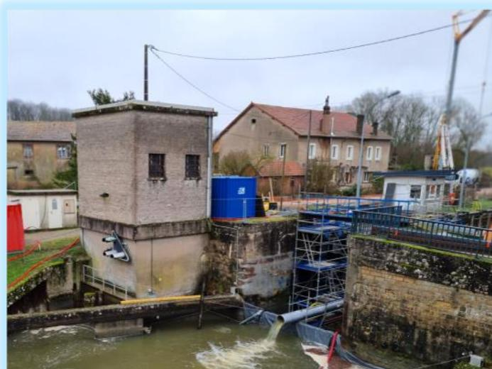
L'écluse n°7 a été le théâtre d'un important chantier de rénovation. Cela a nécessité le barrage du canal, la réfection du canal des pompes, la pose d'une importante dalle pour s'opposer aux infiltrations d'eau, ainsi que le réaménagement de la berge.
