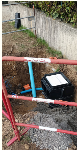
Pose des boîtiers de compteurs d'eau
