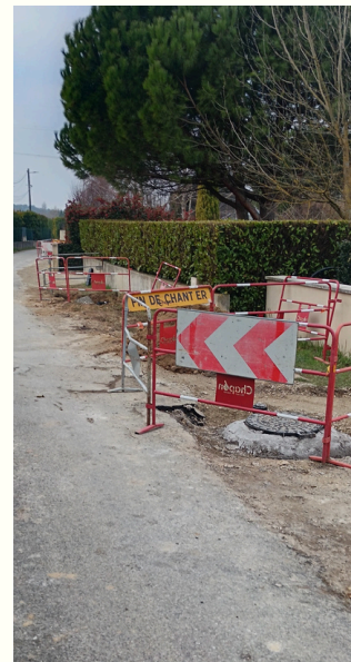
Remplacement des tuyaux
