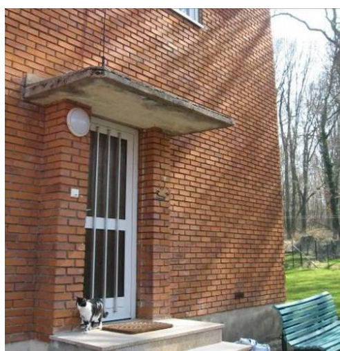
Façade latérale, entrée individuelle
