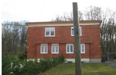
Façade avant côté rue
