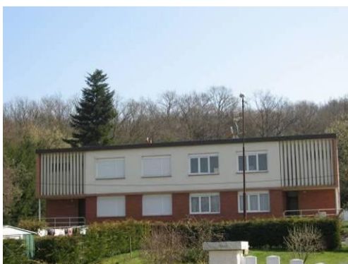
Façade avant donnant sur la rue de la forêt
