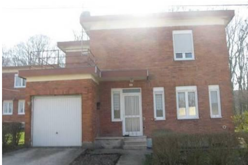
Façade avant sur la rue de la forêt
