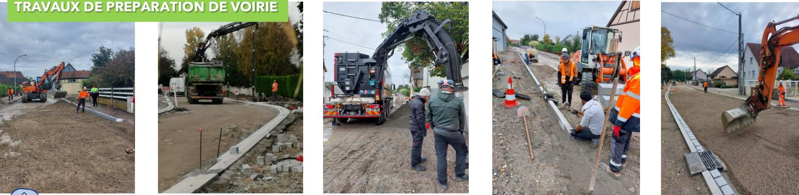
La première phase des travaux a consisté à la mise en place des bordures, caniveaux, mise à niveau et préparation de chaussée ou encore la pose des nouveaux mats d'éclairage.
