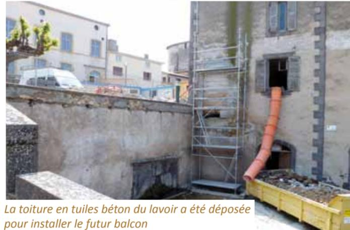
La toiture en tuiles béton du lavoir a été déposée pour installer le futur balcon
