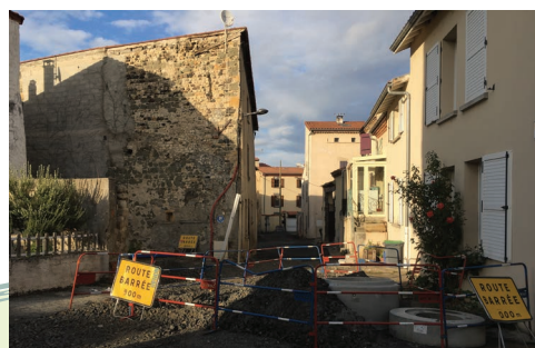
Importants travaux de voirie et de réseaux dans le centre bourg.
