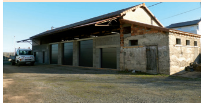
ATELIERS MUNICIPAUX - Réutilisation de ce vieil hangar par les employés municipaux et le SIVOM de l'Albaret : fermeture, reprise du toit, création d'un atelier et d'un réfectoire pour le transfert des ateliers municipaux qui quitteront l'impasse du Cutan à la fin des travaux
