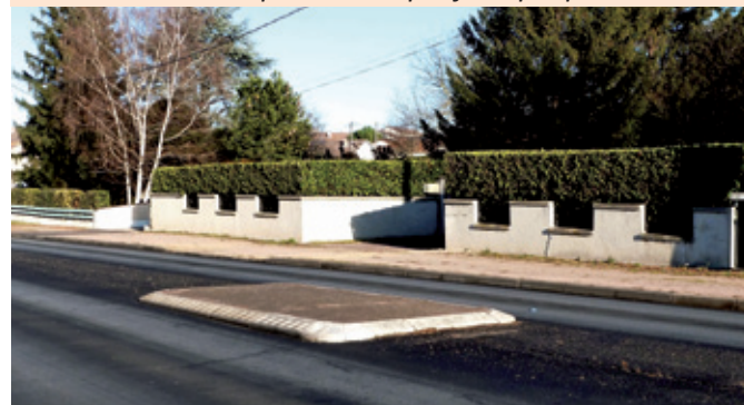
RD 212 - Remise en état des îlots centraux
