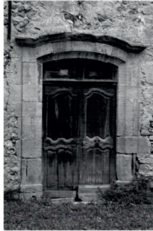
Porte de la Maison de Choin aux Simards
