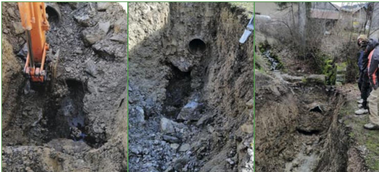
En février, l'entreprise Condevaux a remplacé un aqueduc vétuste en pierre (route des Charrières) par une canalisation de diamètre 800 pour un montant de 7000 €.
