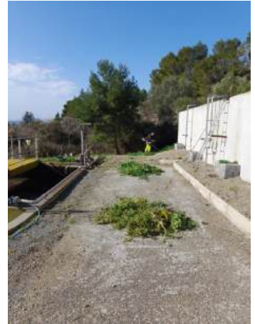
Entretien station épuration
