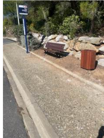
Arrêt de bus Route d'Oupia : installation d'un banc et d'une poubelle.
