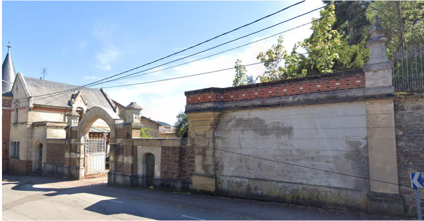
Vue sur l'accès existant depuis la route départementale
