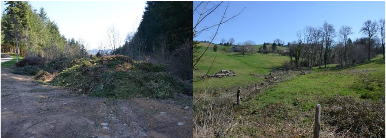
Remblais dans une zone humide de l'inventaire 69 à Barberet coupe d'une ripisylve le long d'un cours d'eau police de l'Eau zone humide de l'inventaire 69 à la Combe (photos Luc Laurent)
