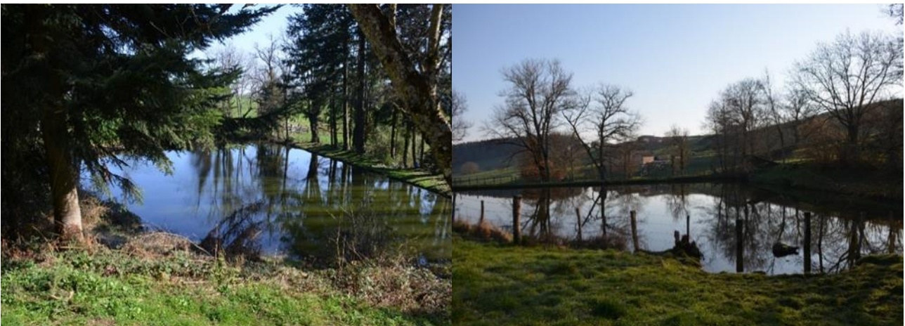
Retenues à Rocheford sud et à Blachon
