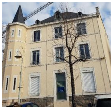
- Maison du département
