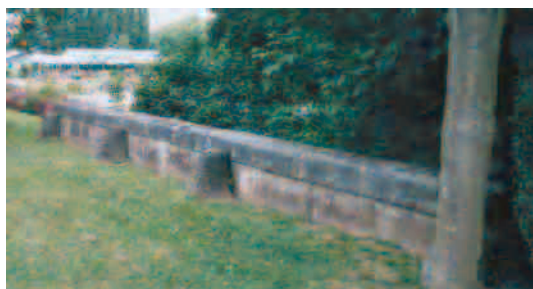
1. Pont sur l'Arré à St-Just
