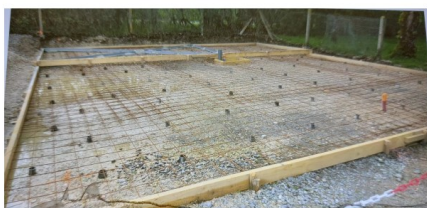
TRAVAUX EFFECTUES PAR LES AGENTS COMMUNAUX
