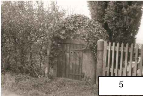
Route Napoléon Le Poteau
