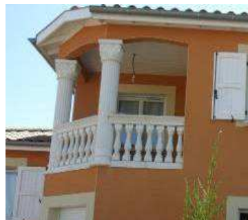
Type de balustres interdites
