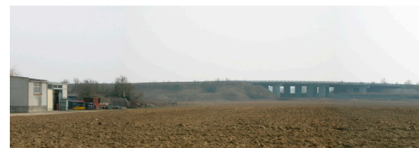
Coupure au Sud de la commune: autoroute et voie SNCF
