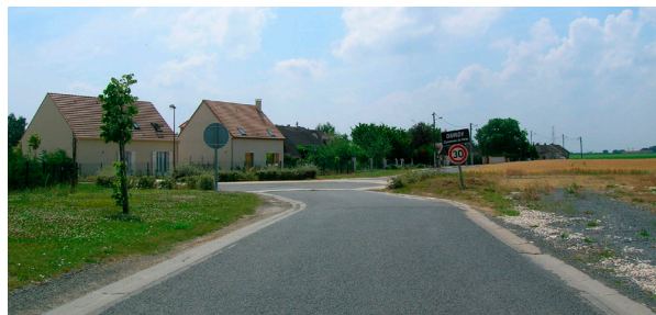
Ourdy, entrée Nord, arrivée sur un rond point
