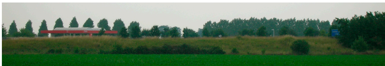
Remblais de l'autoroute A5b en partie végétalisé
