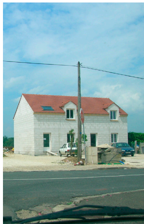
Nouveau bâtiment en construction
