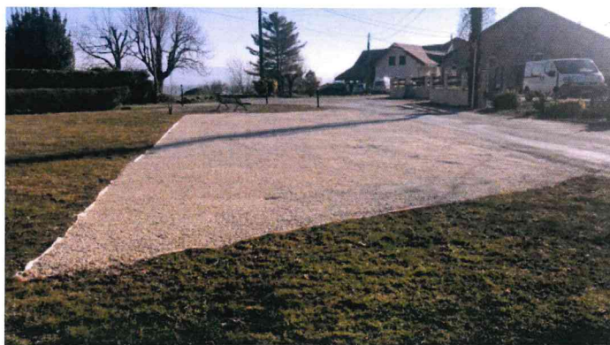
5 nouvelles places de parking public - Rue de la Vie Vieille
