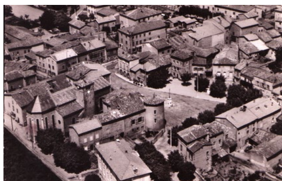
Photo 3 : La place avant les travaux
