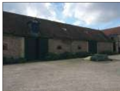
Vue du bâtiment concerné depuis la cour.
