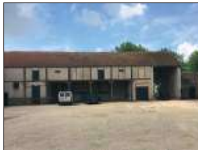
Vue du bâtiment concerné depuis la cour.
