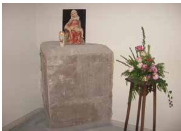
Sous la reproduction de la Pietà de Trois-Epis, installée là provisoirement pour ces portes ouvertes, un contrefort de la chapelle primitive caché habituellement sous l'autel du bas-côté gauche.
