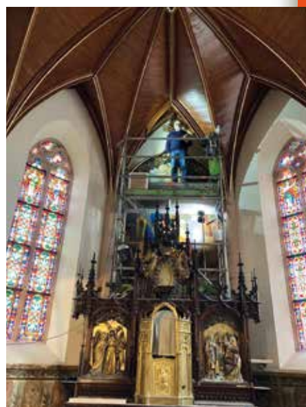
Les voûtes du chœur restaurées par l'entreprise Lammer de Wihr-au-Val, ont retrouvé le bois d'origine, caché jusqu'à présent par un enduit imitant des voûtes en pierre.
