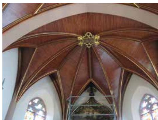
Les voûtes du chœur restaurées par l'entreprise Lammer de Wihr-au-Val, ont retrouvé le bois d'origine, caché jusqu'à présent par un enduit imitant des voûtes en pierre.
