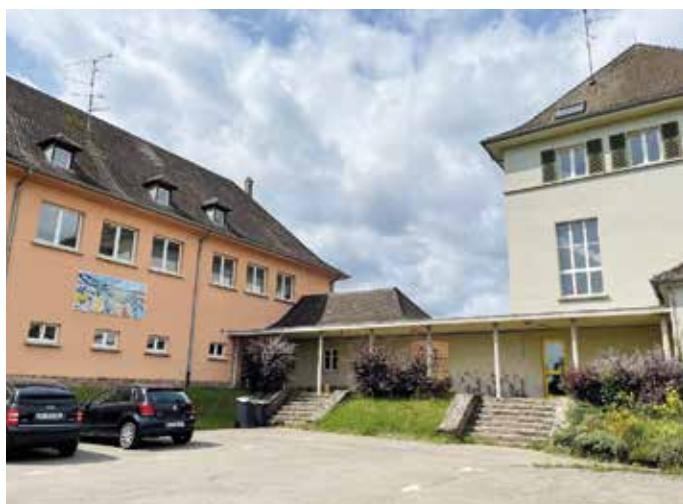
Photos avant travaux depuis le parking des enseignants.
