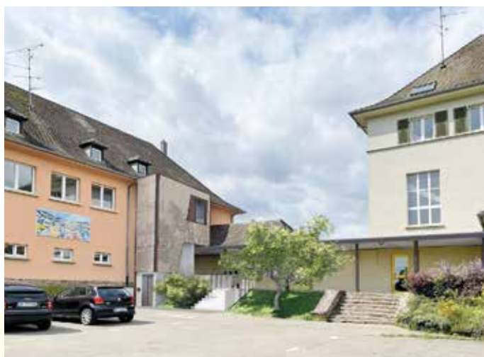
Photos après travaux depuis le parking des enseignants.
