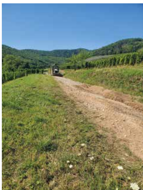
Réfection du chemin du Rumersthal par les services techniques
