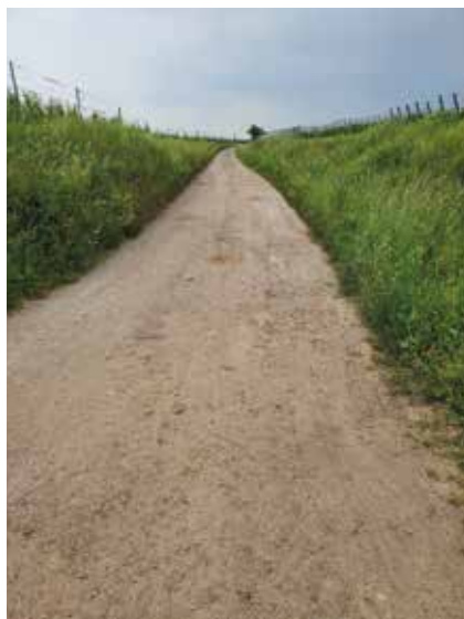
Avant les travaux
