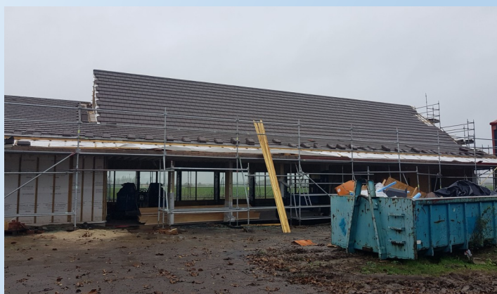
Salle communale toiture en cours
