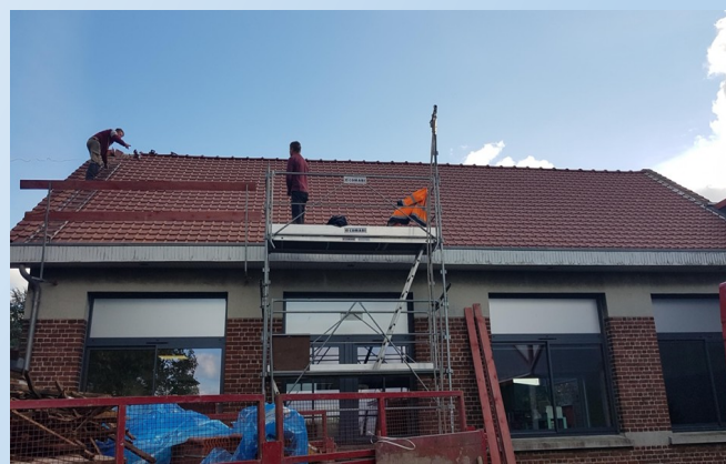
Réfection toiture école
