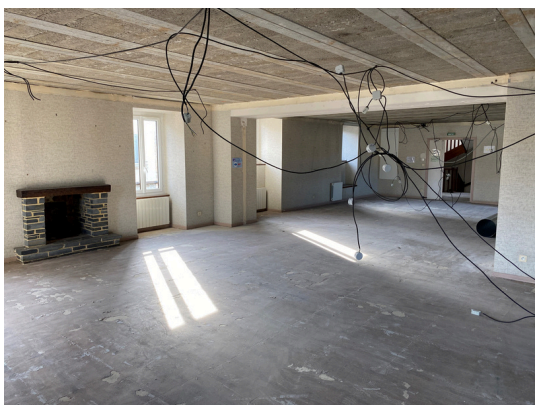
Travaux des salles Bon Accueil
