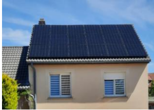
Panneaux posés parallèlement à la pente du toit
