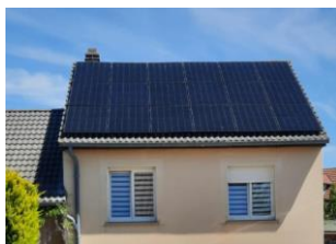
Panneaux posés parallèlement à la pente du toit
