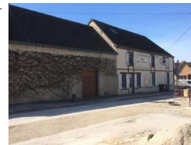
Les travaux de l'axe principal montrent la volonté des élus de le valoriser. Le flux de véhicules y transitant 2 fois par jour est un atout pour envisager le maintien du petit commerce voire l'implantation de nouveaux commerces.
