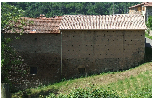
Vue sur le bâtiment (grange)
