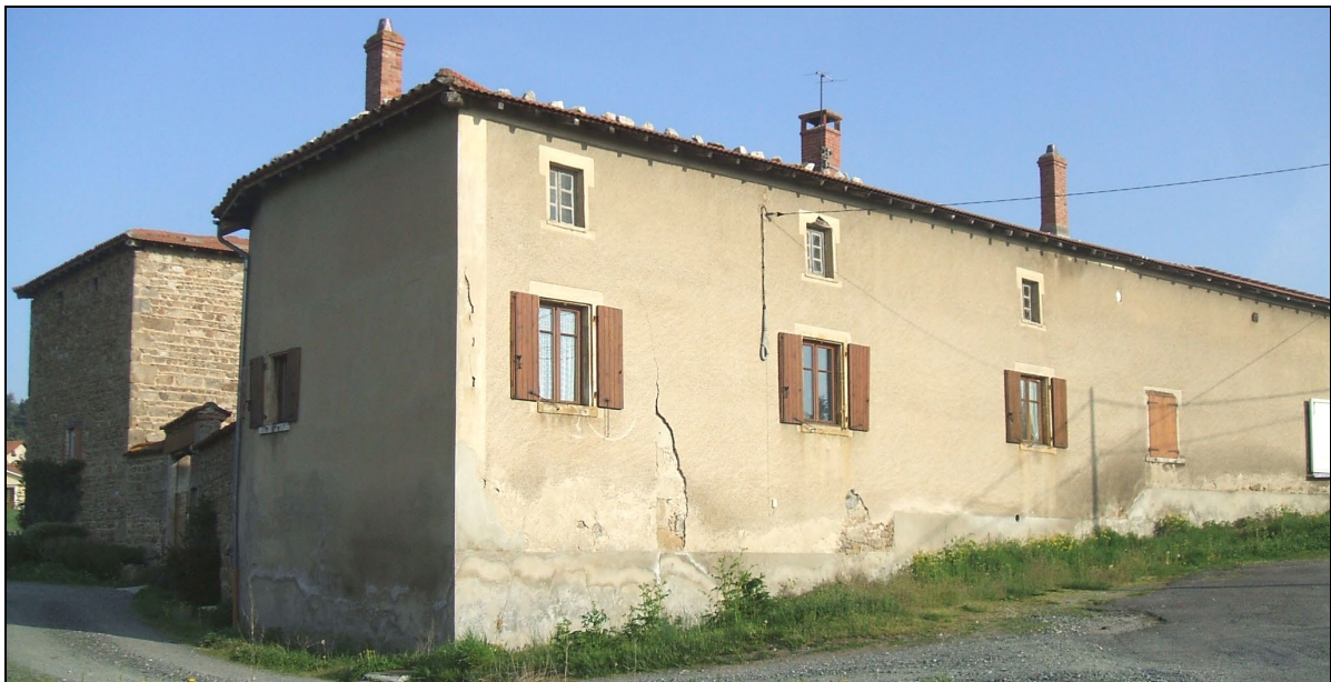
Photographies des bâtiments sur la parcelle B 16
