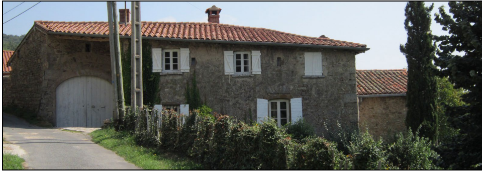
Vue sur la façade ouest du bâtiment
