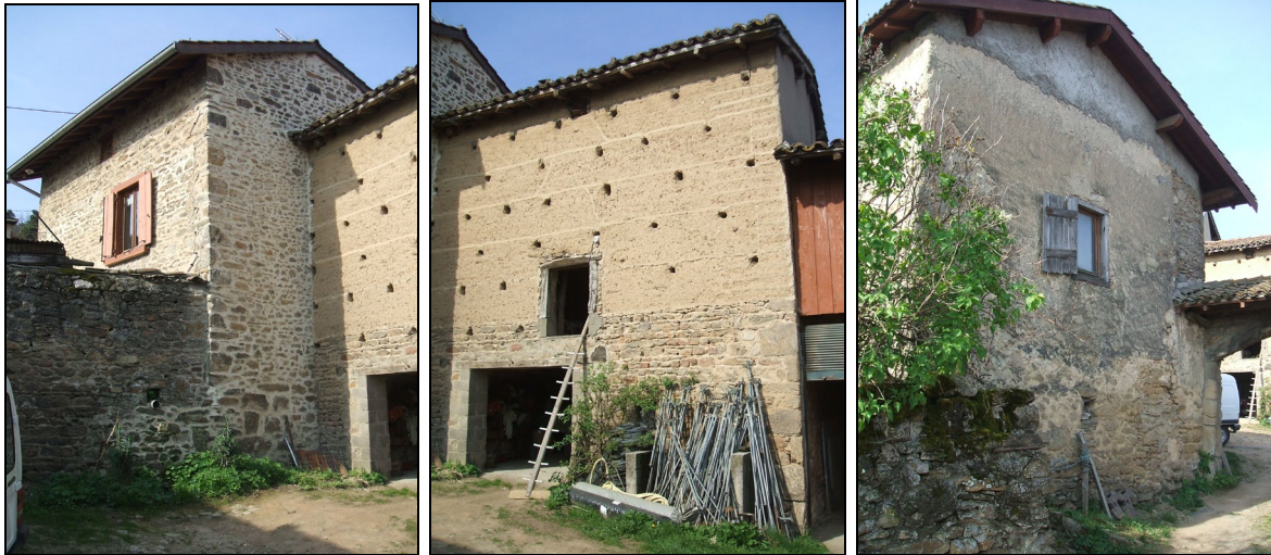
Photos des bâtiments sis parcelle 617, 100 et 616 section F
