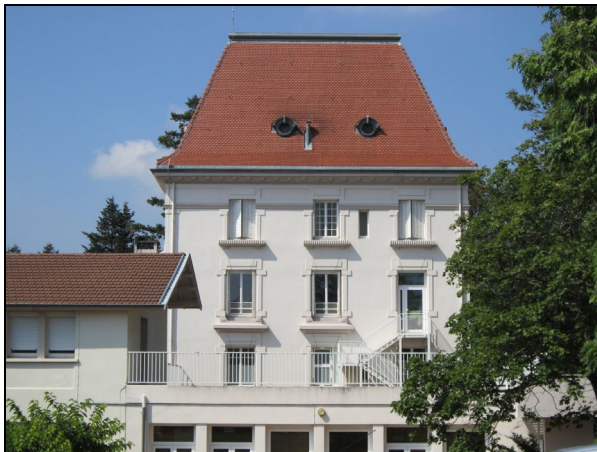
Vue sur les étages de la façade est
