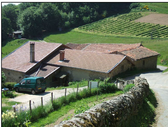
Photographies des bâtiments parcelle K 308
