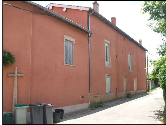
Vue sur la façade est
