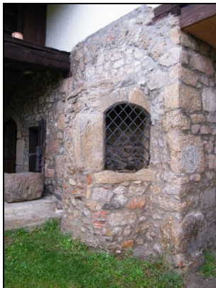
Puits à Maison Blanche
