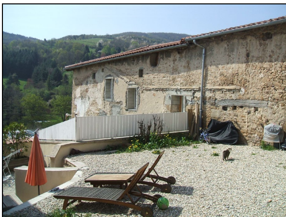
Vue sur le hangar
