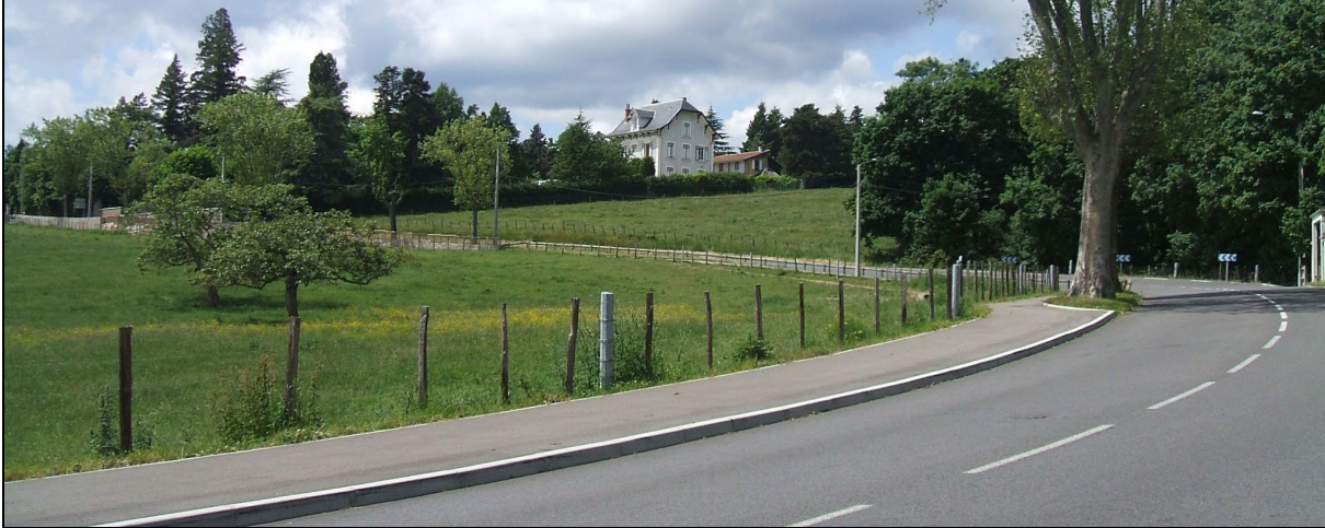
Vue depuis la RD 50 en direction de l'agglomération
