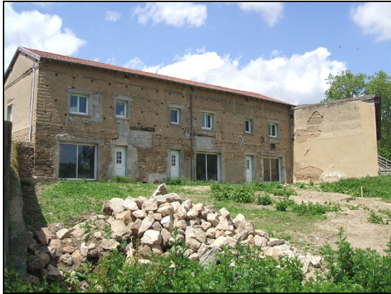
Vue sur la façade est
