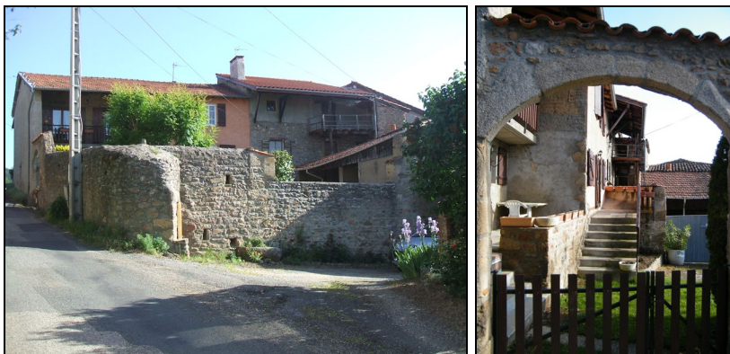
Elément bâti d'intérêt au Crozier
