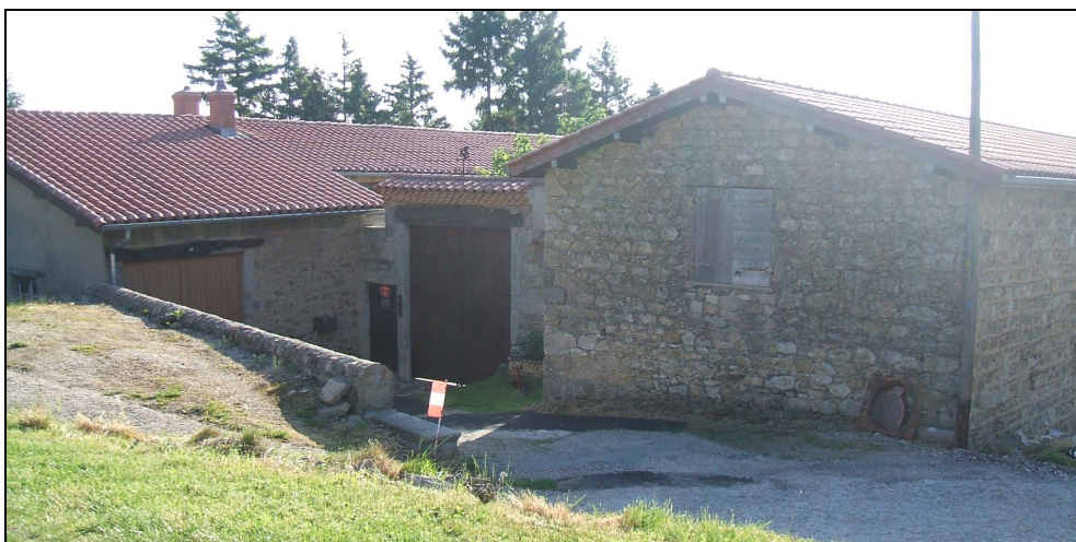
Vue depuis le chemin des Gouttes
