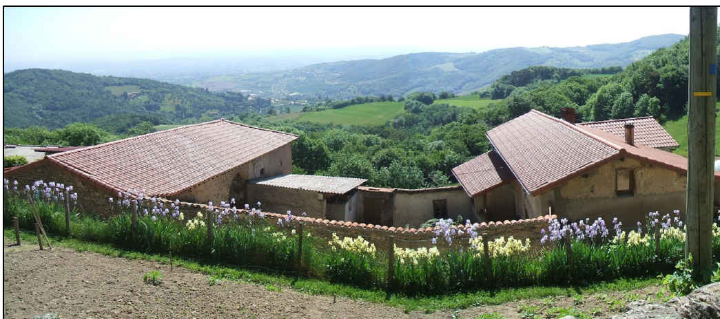
Photographies des bâtiments parcelle K 310
