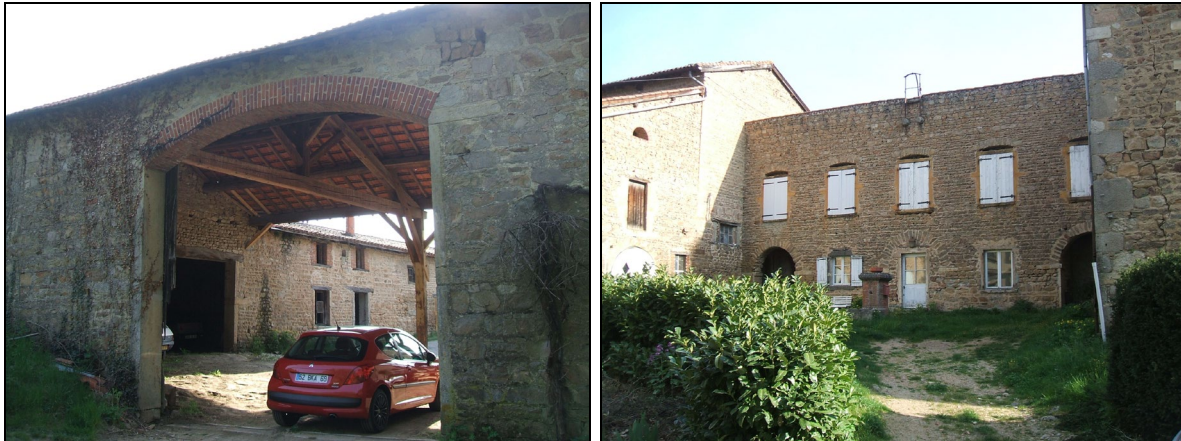
Photo des bâtiments situés parcelles 706 et 708
