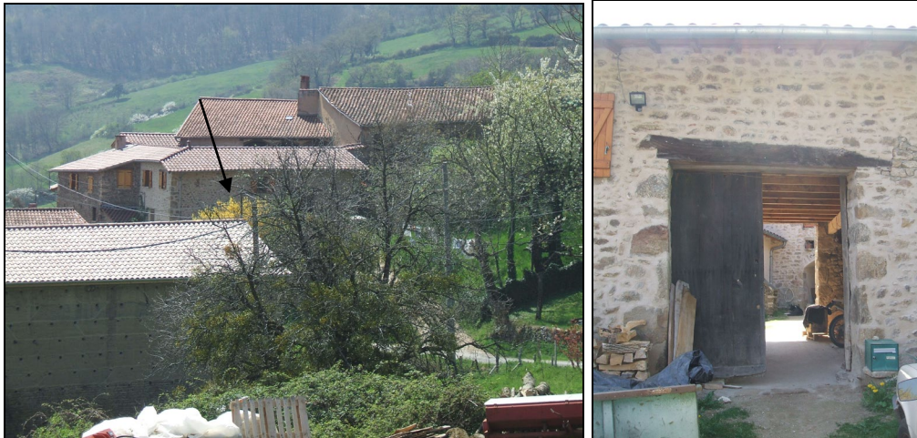
Photographie du bâtiment sis parcelle K 75
