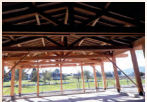
Avancement des travaux de la salle d'évolution
