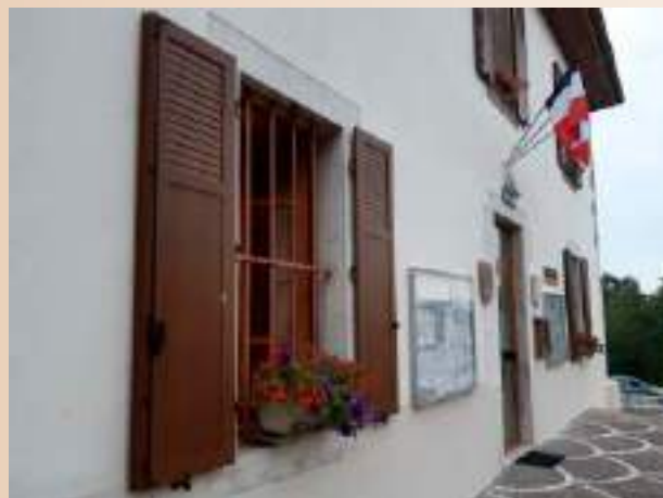
Les volets, touche finale de la rénovation de la mairie
