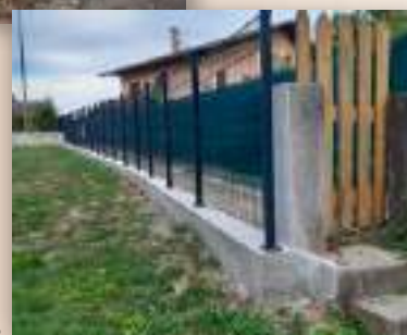
Un nouveau muret surplombé d'un grillage
