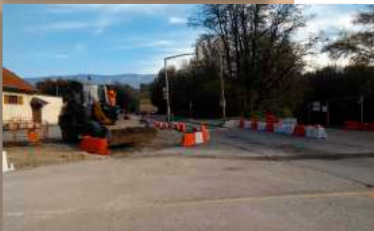
Lourd chantier au chef lieu
