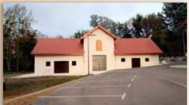
...et après les travaux.
