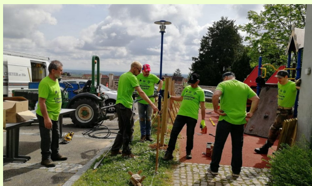
Mise en place d'une clôture en bois à l'aire de jeu de la salle des fêtes
