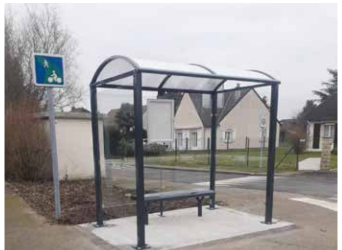
Abribus à l'angle des rues des Bruyères et des Goubins
