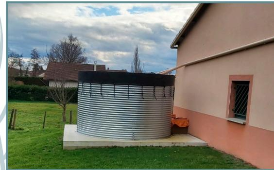
Pour répondre au besoin en eau, pour l'arrosage des fleurs ou le nettoyage des véhicules, une cuve de 20M/Cubes a été disposée le long du local technique, afin de récupérer les eaux de pluie de la toiture.
