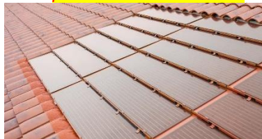
Image : Rémi Portier, Piguët SAS ↑ Autorisé : Panneaux intégrés, teinte avoisinante à celle des tuiles
