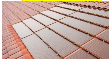
Image : Rémi Portier, Piguët SAS ↑ Autorisé : Panneaux intégrés, teinte avoisinante à celle des tuiles
