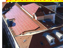
Image : BISOL ↑ Autorisé : Panneaux en surimposition, teinte avoisinante à celle des tuiles
