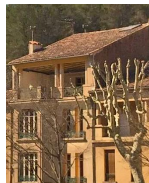
Exemple au nu de la façade
