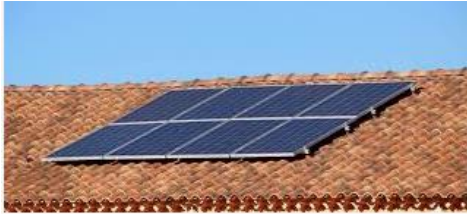
↑ Autorisé : Panneaux en surimposition parallèlement à la toiture
