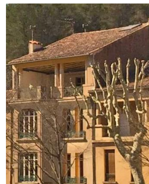
Exemple au nu de la façade
