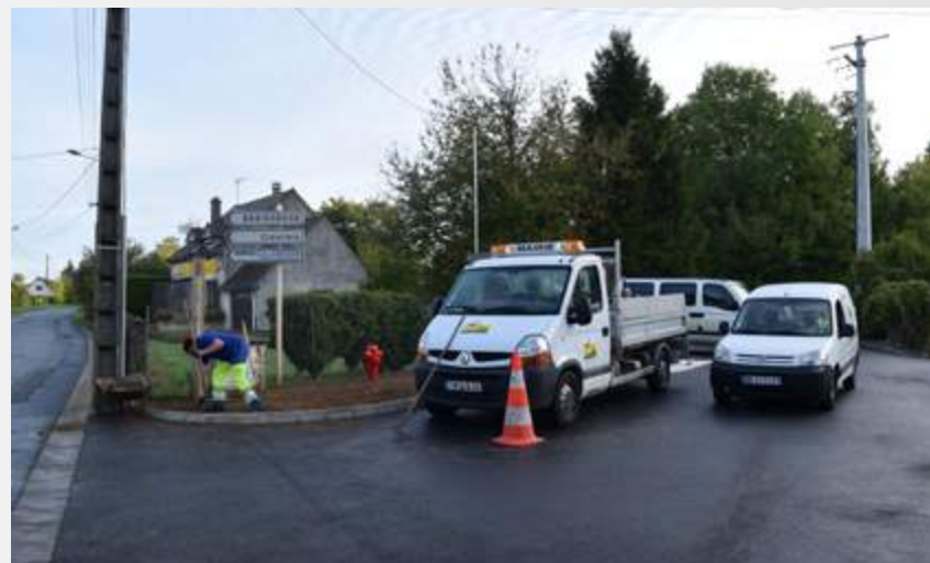
Rue de la Croisette APRÈS
