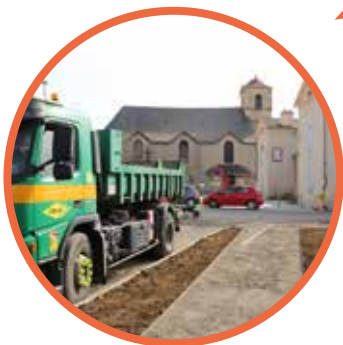
Travaux en cours au Cœur historique
