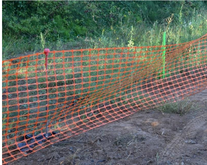
☞ Photographie 17 : Dispositif de limitation des emprises des travaux
