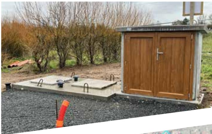
Des travaux ont également été réalisés rue de la Gare, où la pompe de relevage d'assainissement a été rénovée et déplacée de quelques mètres sur un terrain récemment acquis auprès du département. Une canalisation de refoulement a été mise en place, raccordée au système gravitaire, rue de l'Auriet. Ces travaux sont financés par Cholet Agglomération.
