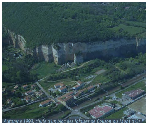
Automne 1993, chute d'un bloc des falaises de Couzon-au-Mont-d'Or
