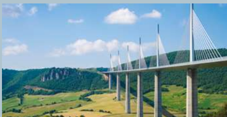
Le Viaduc de Millau
