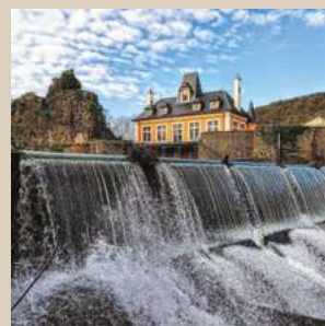
Centrale hydroélectrique d'Ambialet @patprp
