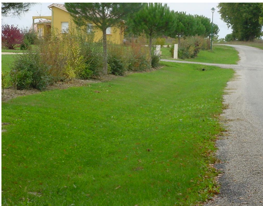
Accotement (collecte des eaux) végétalisé
