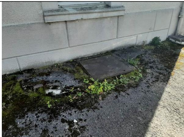
Photo 5 : Ancienne cuve fioul en place non utilisée
