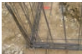
Noeud de chaînage - Continuité mécanique
