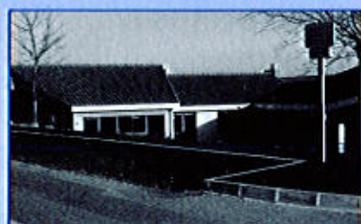
Création d'un arrêt minute pour la sécurité des enfants devant le groupe scolaire.
