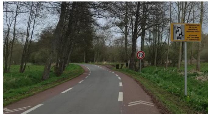
**Voie où les véhicules motorisés circulent sur une voie centrale et les cyclistes sur les bandes de rive.**
