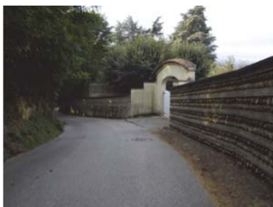
Mur : rue Saint-Jean
