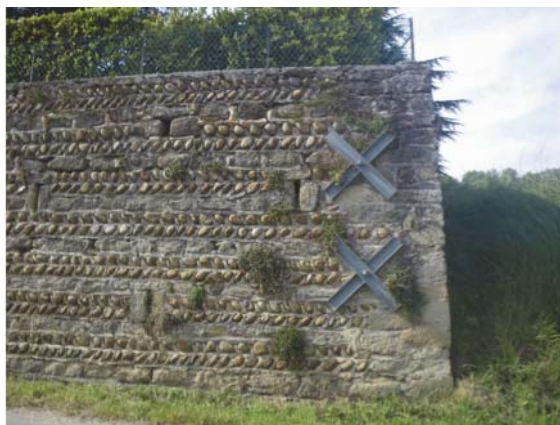
Mur : Propriété Leclerc
