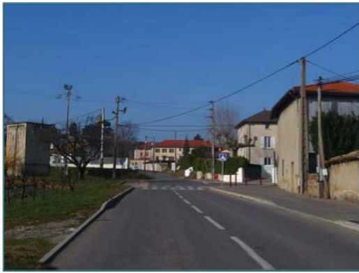
Route de Vernioz récemment sécurisée
